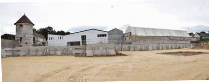
Ensuite, il a fallu creuser la totalité du futur sous-sol et parallèlement projeter le béton pour réaliser les murs circulaires. La dernière opération a consisté à effectuer le traitement du sol à la chaux pour conforter le sol.
